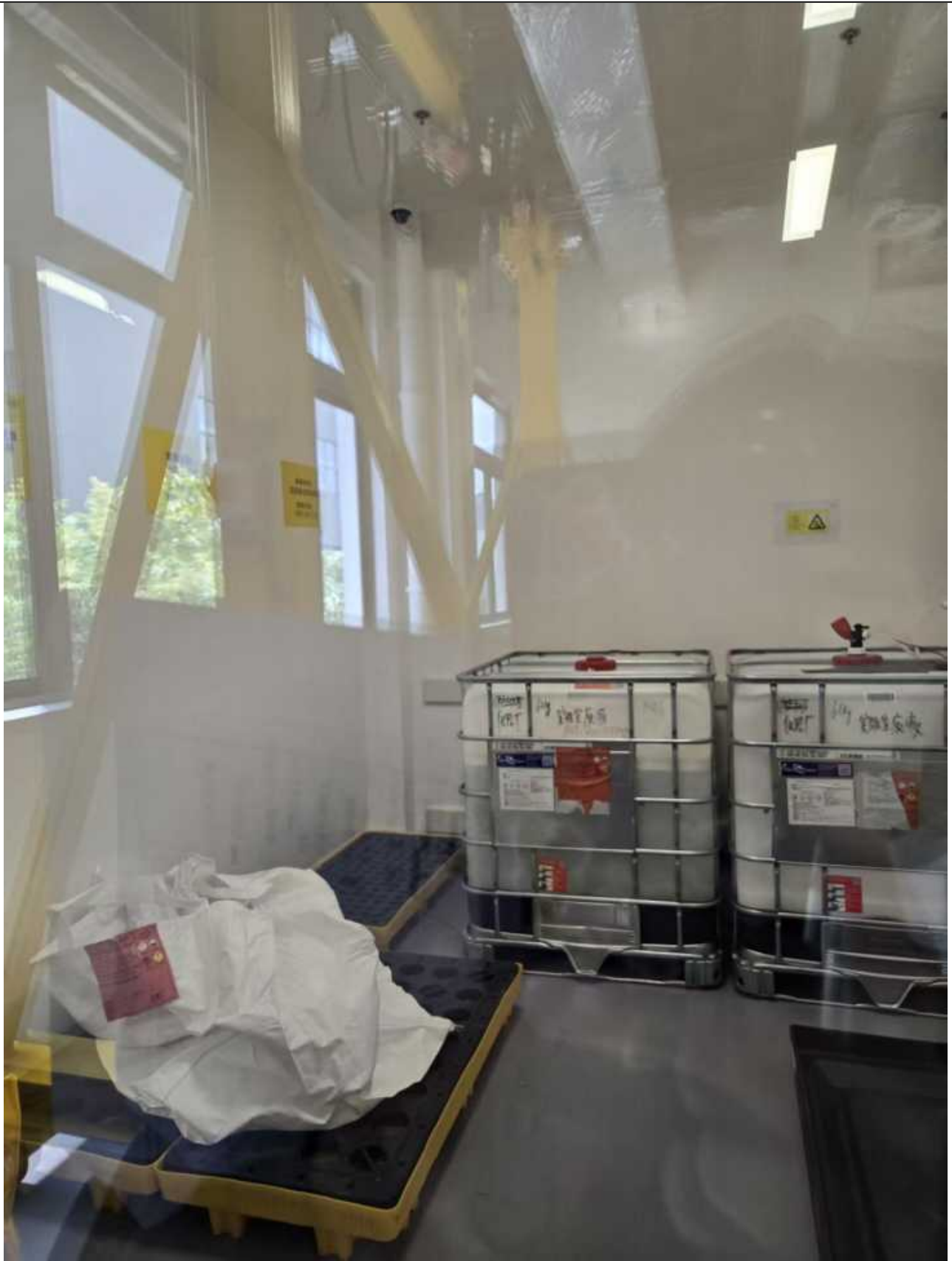
危废仓库（监控、照明设施、防渗防漏设施）
