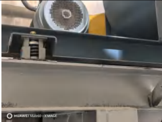
图 4-2 设备减振装置
