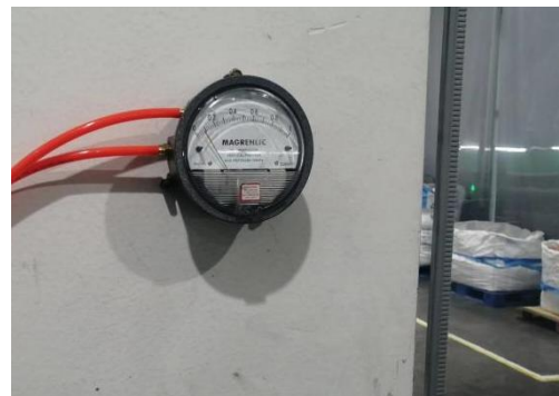
靠软帘内侧安装的差压计
